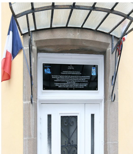
Le nouveau portail d'entrée de la Mairie d'Hauterive
